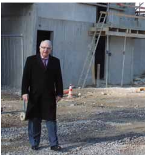
Chantier des 32 logements rue des Blés d'Or, livraison 1 er semestre 2012
